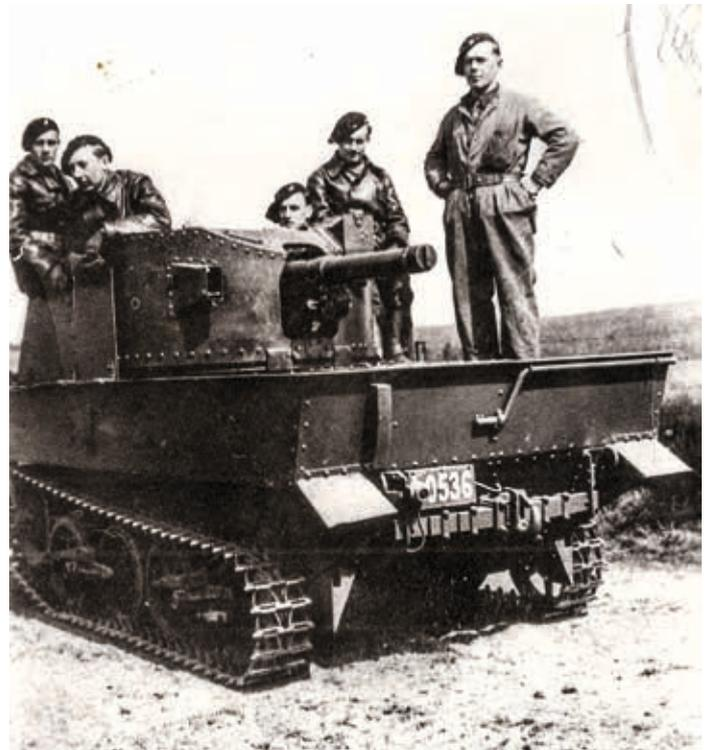
T-13B2 et son équipage. Le canon FRC de 47 mm dont il est armé est une redoutable pièce antichar. En mouvement, l'arme est pointée vers l'arrière et c'est aussi en marche-arrière que le véhicule est habituellement mis en position de tir. ♦
